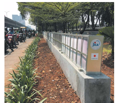
ジャカルタ市南部の幹線国道シマトゥパンに設置された大気浄化装置 写真提供：大阪ガス/大阪ガスエンジニアリング
